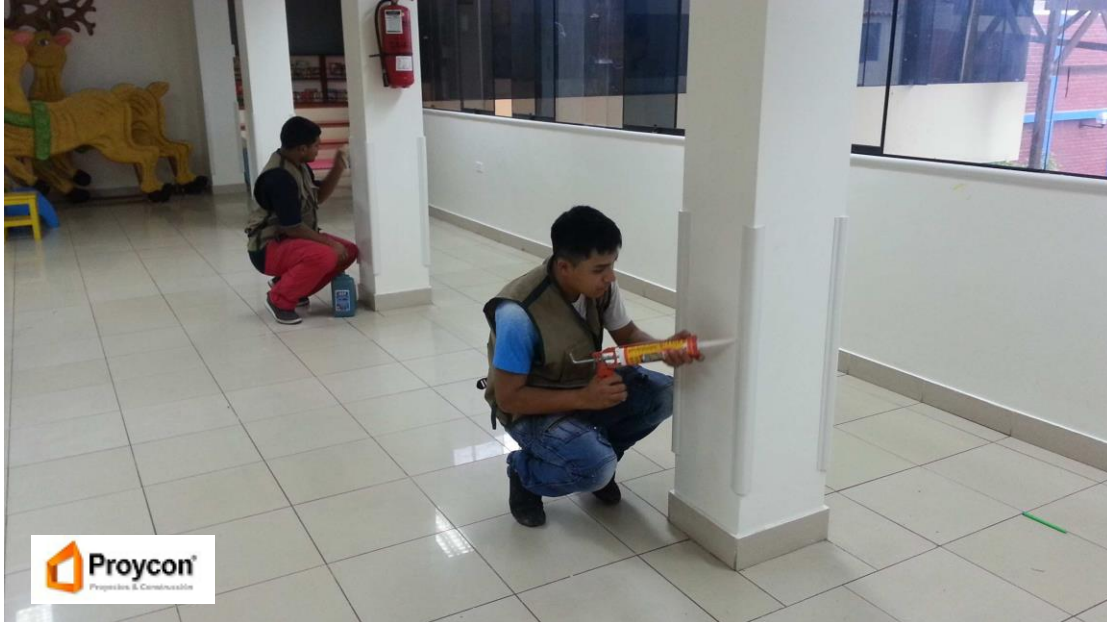
Instalación en las columnas de los centros educativos (Inicial – Primaria)
