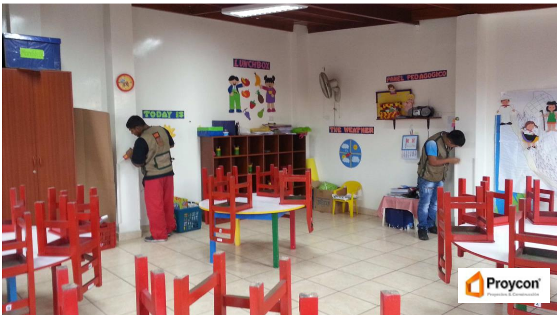
Instalación en esquinas de columnas dentro del salón de clases
