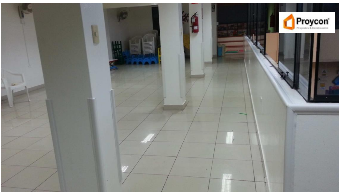
Instalación Columnas, parapetos y bordes de ventanas
